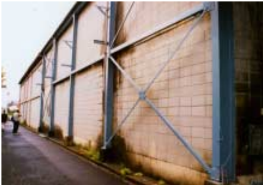
写真15 無被害のブロック造帳壁（境港市米川町）
