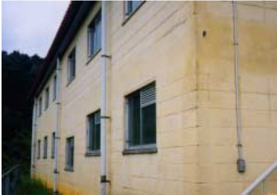
写真14 無被害の2階建補強コンクリートブロック造部室兼倉庫（西伯町馬場）
