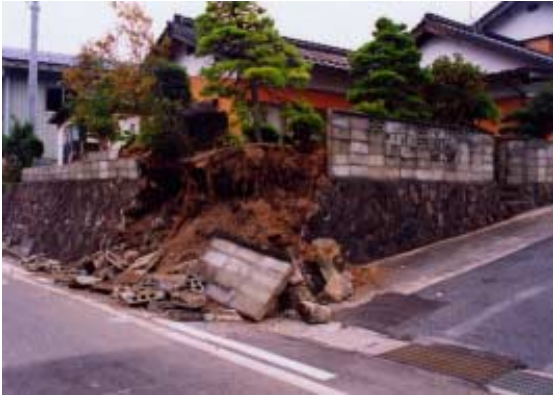
写真22 擁壁およびブロック塀の崩壊(日野町黒坂)
