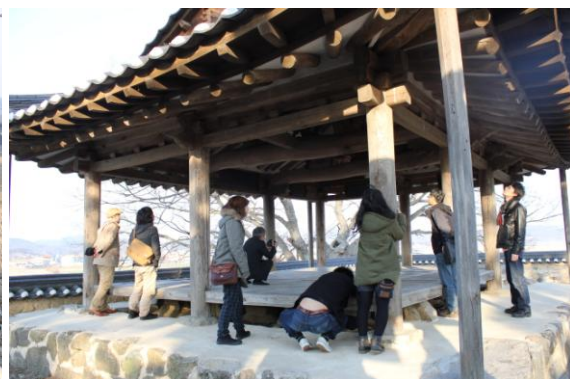
図 18 三亀亭の梁の様子
