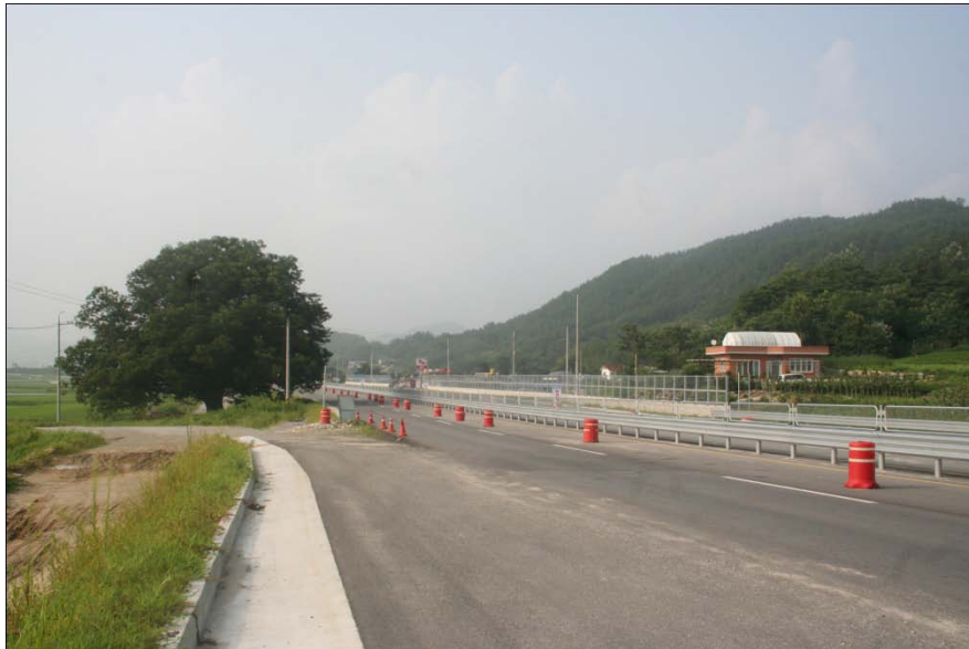
集落前面道路の拡張整備
