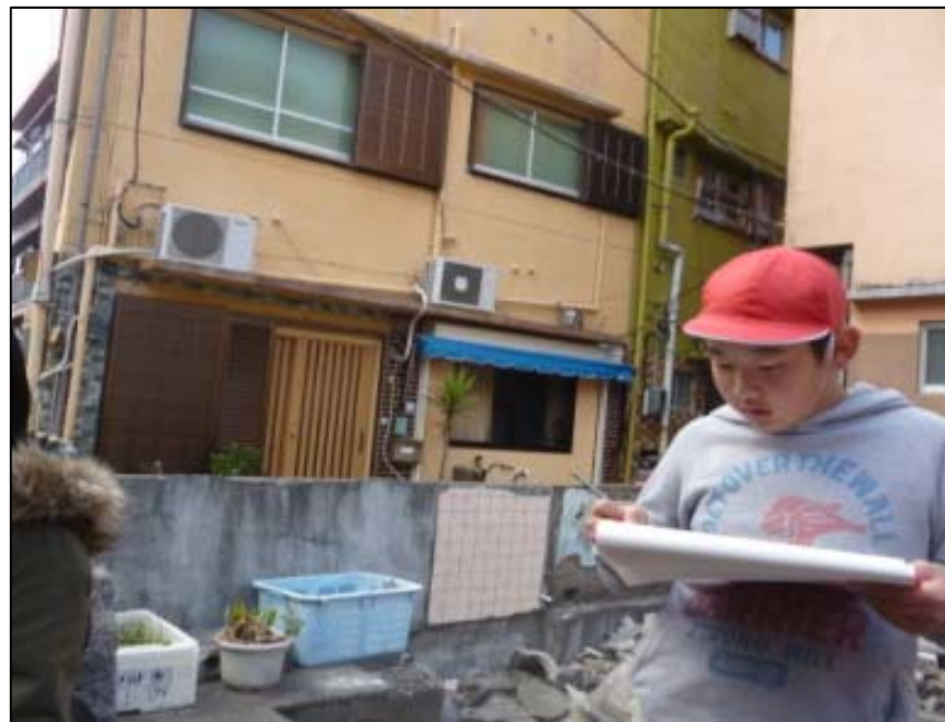
【点検中の様子】
