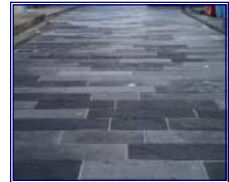
④道路舗装
