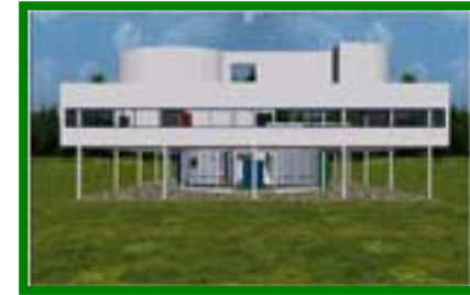
Group5: 水平連続窓のある外観
